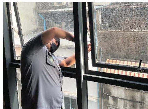
เจ้าหน้าที่ฝ่ายช่างตรวจสอบ และซ่อมแซมหน้าต่างระบายอากาศ
